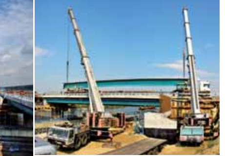
Ryc. 15. Montaż ostatniego przęsła belek VFT®
