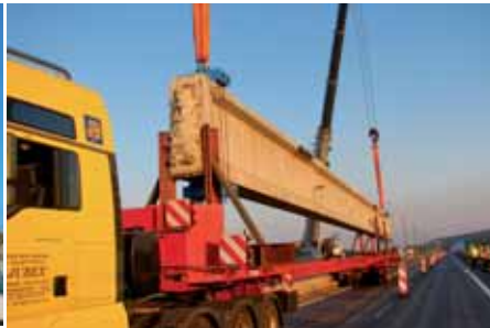
Ryc. 11. Transport dźwigarów WBS
