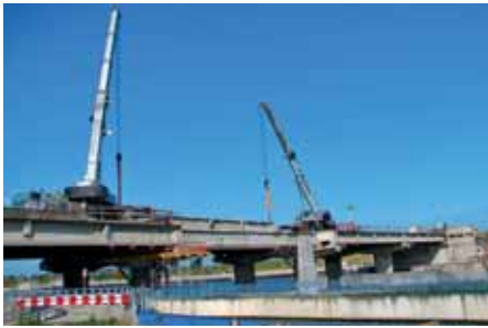
Ryc. 10. Demontaż belek WBS
