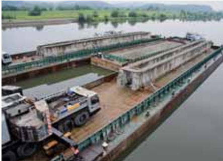
Ryc. 13. Zabezpieczenie dźwigów i belek balastowych na barkach
