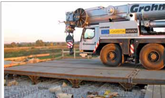
Ryc. 6. Dźwig w trakcie najazdu na platformę
