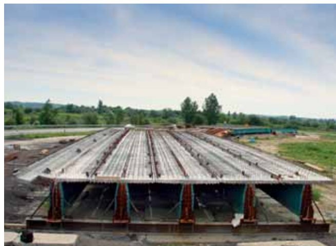
Ryc. 4. Belki VFT® na polu prefabrykacji
