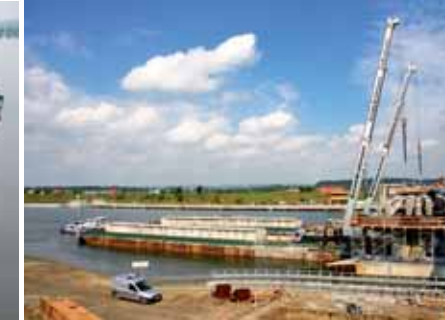
Ryc. 14. Barki w czasie demontażu belek WBS
