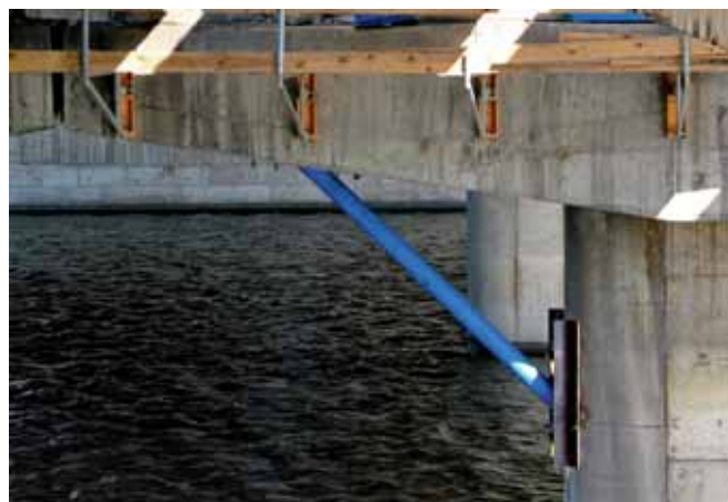
Ryc. 3. Wzmocnienie filaru mostu – lewa jezdnia (kierunek Balice)
