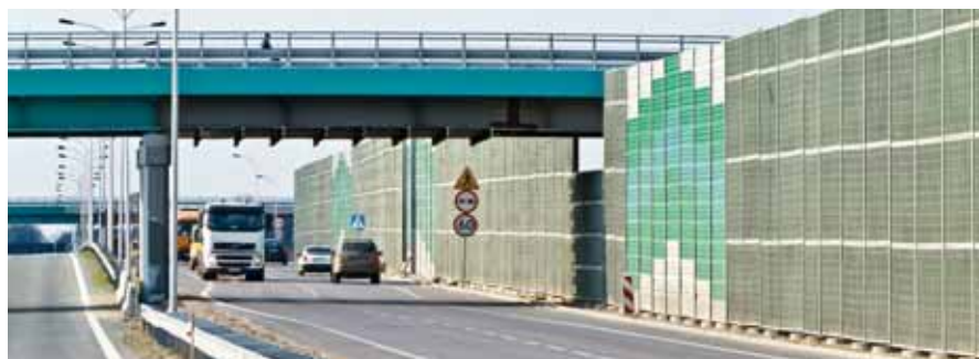
Droga krajowa nr 7, odcinek Białobrzegi – Jedliński
