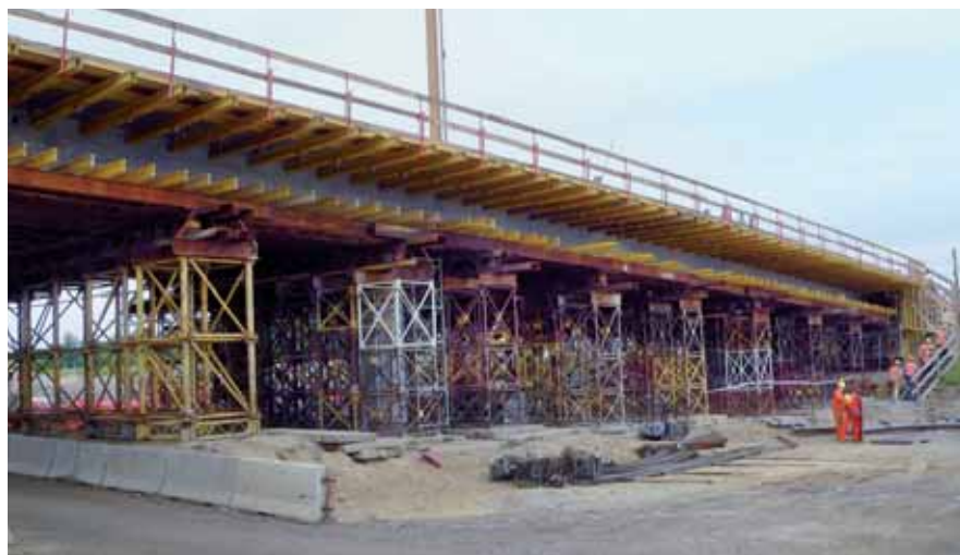
Budowa autostrady A-4, odcinek Kraków – Szarów, wykonawca Polimex-Mostostal SA
