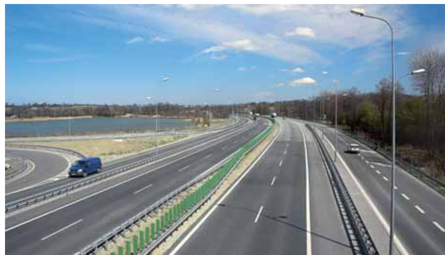
Obwodnica Skoczowa, wykonawca Polimeks-Mostostal SA
