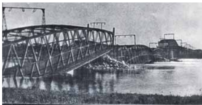
Zniszczenie mostu Fordońskiego dokonane 2 września 1939 r.
