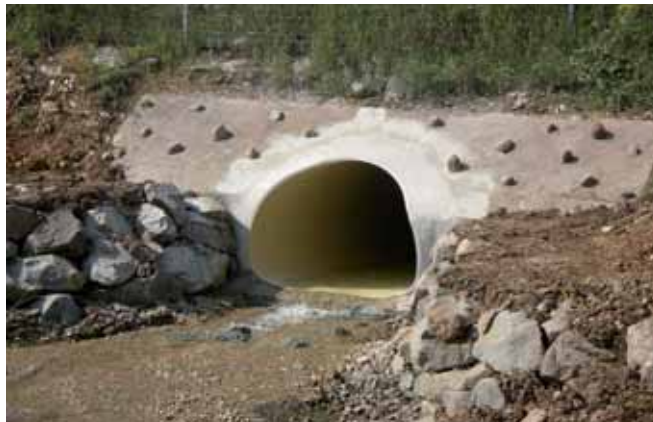
Ryc. 7. Przykład przepustu zrealizowanego z rur CC-GRP, fot. Hobas Polska Sp. z o.o.
