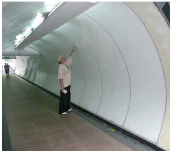
Ryc. 16. Przykład estetycznego, dobrze utrzymanego przejścia dla pieszych, fot. A. Wysokowski
