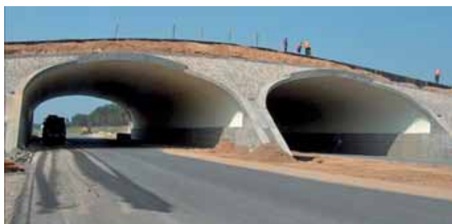
Ryc. 11. Przykład zastosowania nowoczesnych przepustów do budowy przejść dla dużych zwierząt (autostrada A-2), fot. ViaCon Polska Sp. z o.o.
