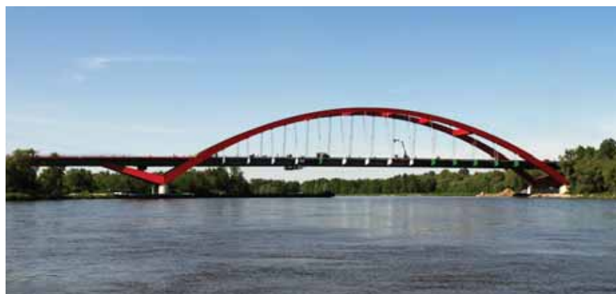
Budowa nowej przeprawy mostowej w Puławach, fot. Łukasz Józwiak/GDDKiA
