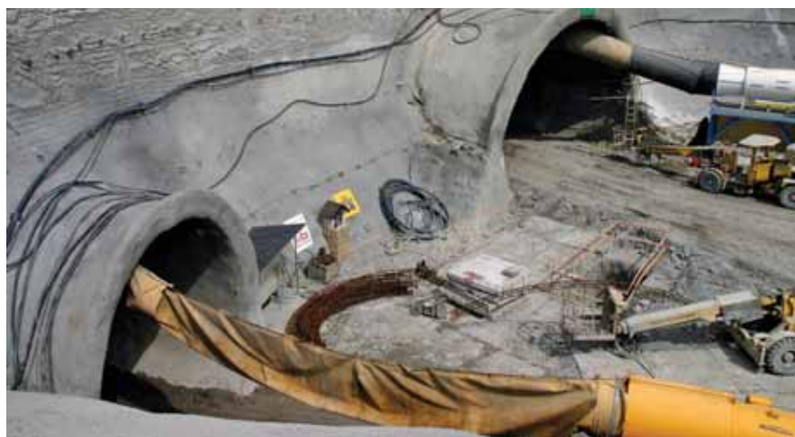
Budowa tunelu w Lalikach
