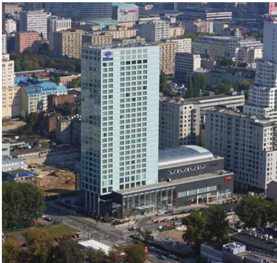
Hotel Hilton przy ul. Grzybowskiej w Warszawie, wykonawca Budimex Dromex SA, 2004–2007
