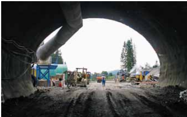
Portal południowy tunelu w Lalikach – widok ze środka
