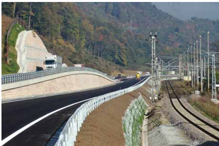
Mury oporowe na drodze szybkiego ruchu R1 w miejscowości Rudno – Żarnowica
