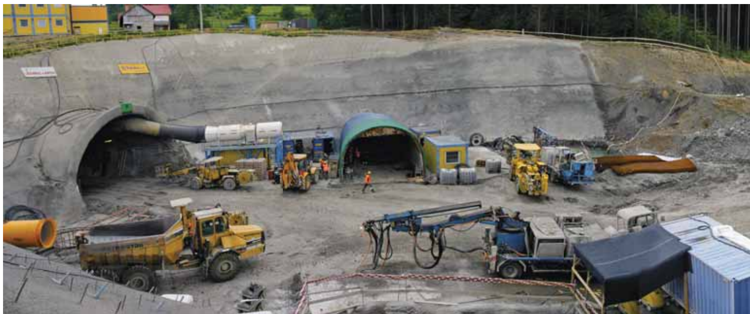
Portal południowy tunelu w Lalikach
