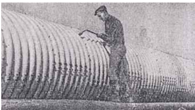
Ryc. 25a. Montaż przepustu ze stalowych blach karbowanych (ZSRR)
