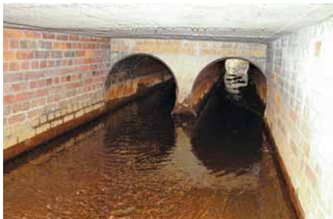
Ryc. 16. Przykład dwukomorowego przepustu o konstrukcji z wykorzystaniem rur stalowych o gładkich ściankach, fot. Z. Kubiak
