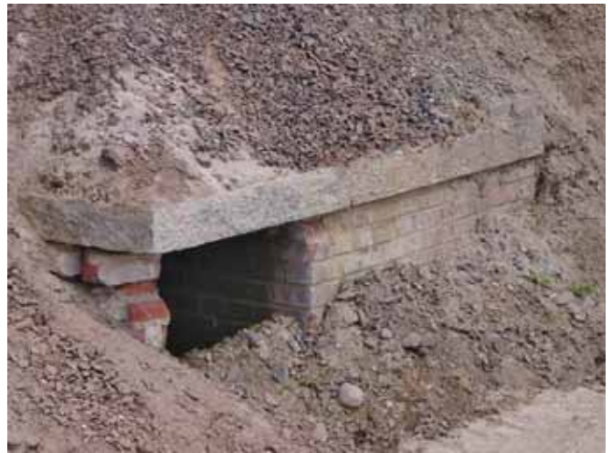
Ryc. 6. Przepust z płytą kamienną, fot. Z. Kubiak
