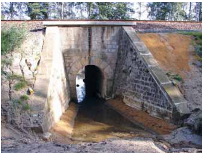
Ryc. 4. Typowy kamienny przepust kolejowy o konstrukcji sklepionej, fot. Z. Kubiak
