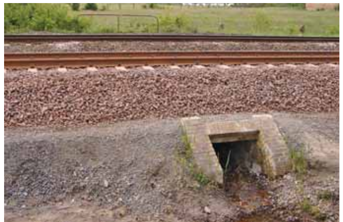
Ryc. 8. Przepust o konstrukcji ceglano-betonowej w ciągu linii kolejowej, fot. Z. Kubiak
