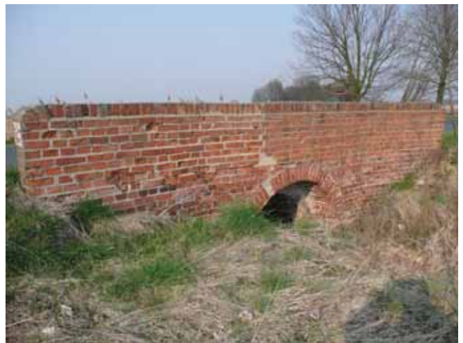
Rys. 7. Tradycyjny ceglany przepust sklepiony w ciągu drogi powiatowej na terenie Dolnego Śląska, fot. A. Wysokowski
