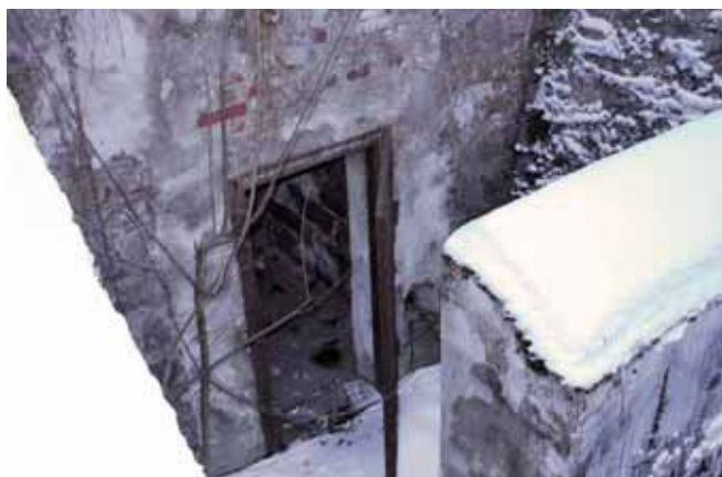
Ryc. 17. Przykład nietypowego przepustu zaadaptowanego na schron, fot. Z. Kubiak
