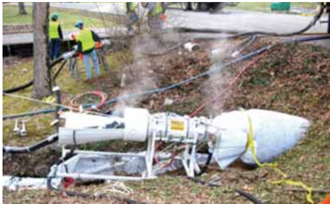
Renowacja przepustu drogowego
