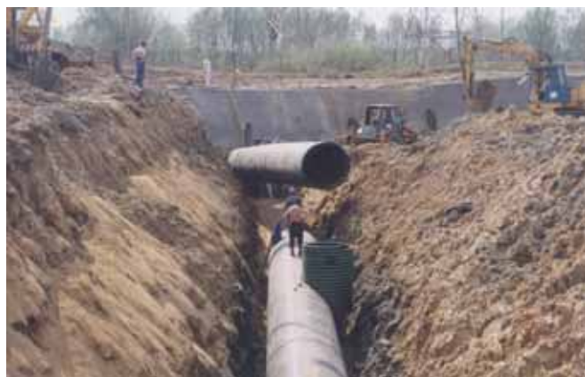
Przykład kolektora kanalizacyjnego wykonanego systemowo z rur i studni z polietylenu. Średnica kolektora 1500 mm
