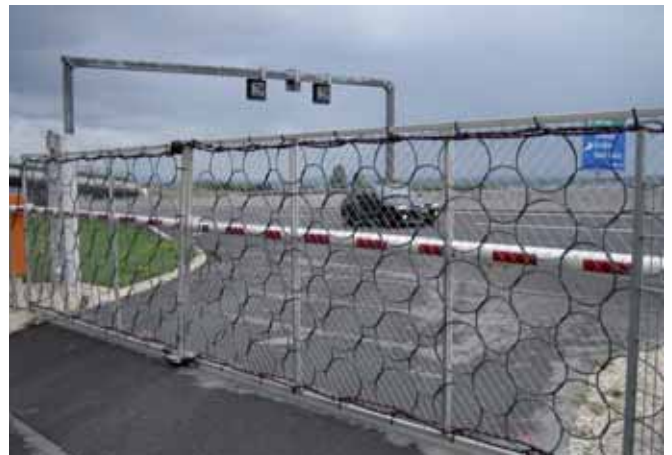
Ryc. 5. Bariera na przejeździe kolejowym, Yverdon, Szwajcaria
