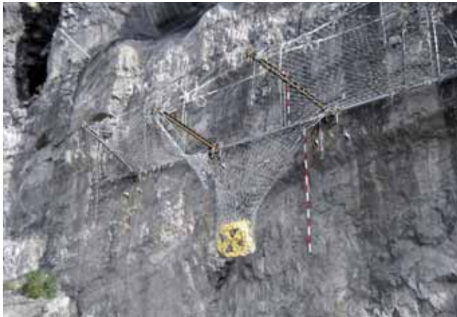
Ryc. 4. Bariera RXI-500 o nośności dynamicznej 5000 kJ, po zatrzymaniu bloku skalnego o masie 16 000 kg, spadającego pionowo z wysokości 32 m!
