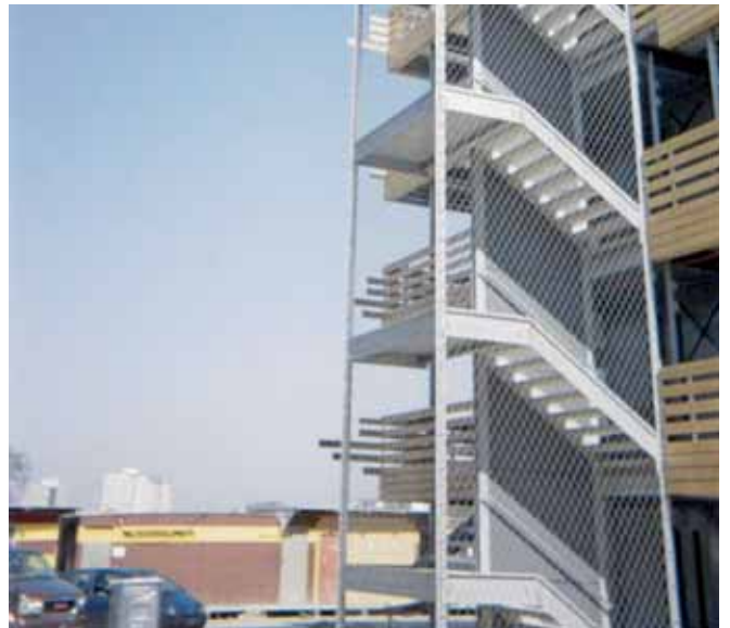
Ryc. 10. Klatka schodowa w Szwajcarii. Siatki zabezpieczające przed wypadnięciem
