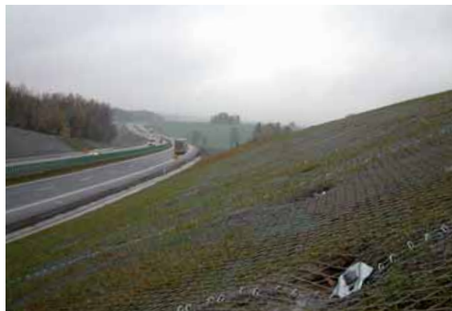
Ryc. 1. Skarpy w ciągu drogi S1, Grodziec Śląski, pokryte systemem TECCO®
