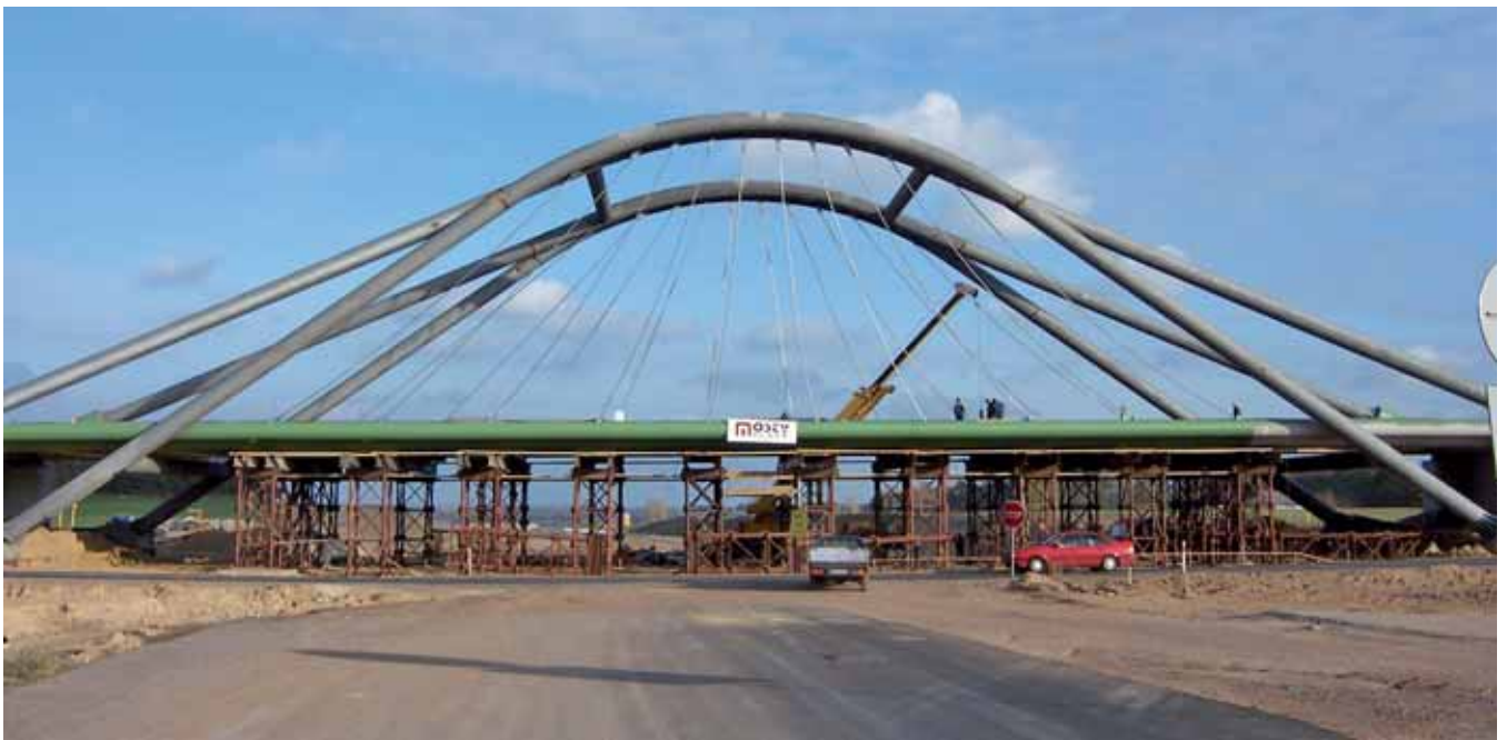
Ryc. 8. Most lukowy WD161 nad autostradą A2 węzeł Koło pod Koninem. Zastosowano ciągną linowe Brugg VWS3, o średnicy 64 mm
