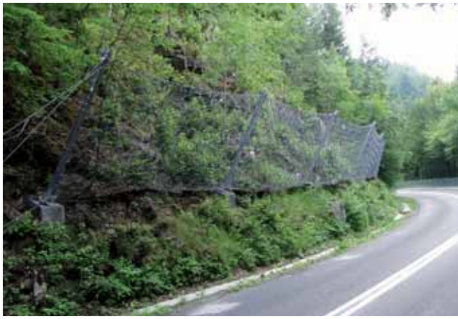
Ryc. 2. Bariera RXI-025 chroniąca drogę nr 971, Żegiestów k. Nowego Sącza
