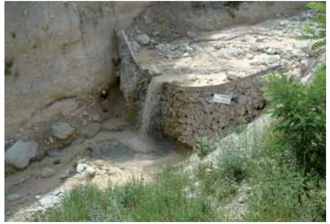
Ryc. 3. Bariera w Szwajcarii, po zatrzymaniu sływu gruzowego o objętości ponad 1000 m 3
