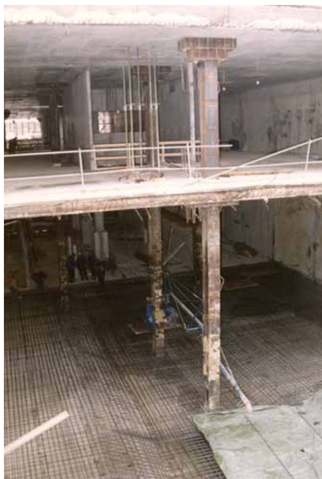
Ryc. 2. Oparcie stropów na słupach tymczasowych na stacji metra A15 „Ratusz”
