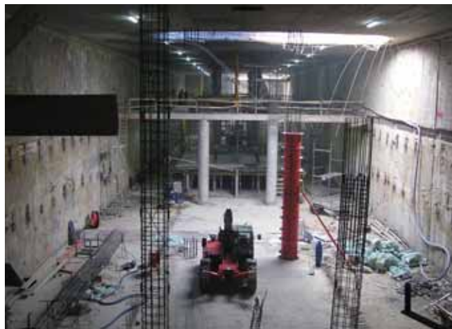
Ryc. 5. Wnętrze stacji A19 „Marymont” po zabetonowaniu płyty dennej
