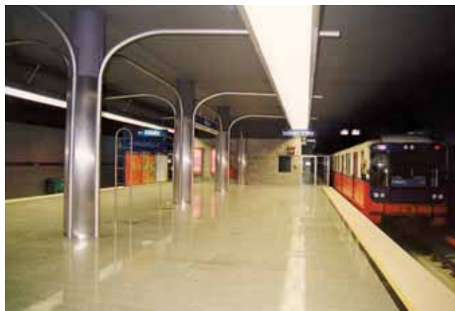
Ryc. 1. Widok hali peronowej stacji metra warszawskiego A15 „Ratusz”
