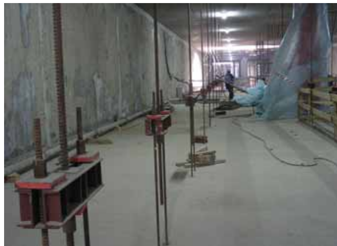
Ryc. 3. Rząd odprężonych wieszaków po podparciu stropu pośredniego słupami na stacji metra A19 „Marymont”
