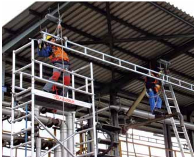
Montaż systemu kratownicowo-szynowego Traser
