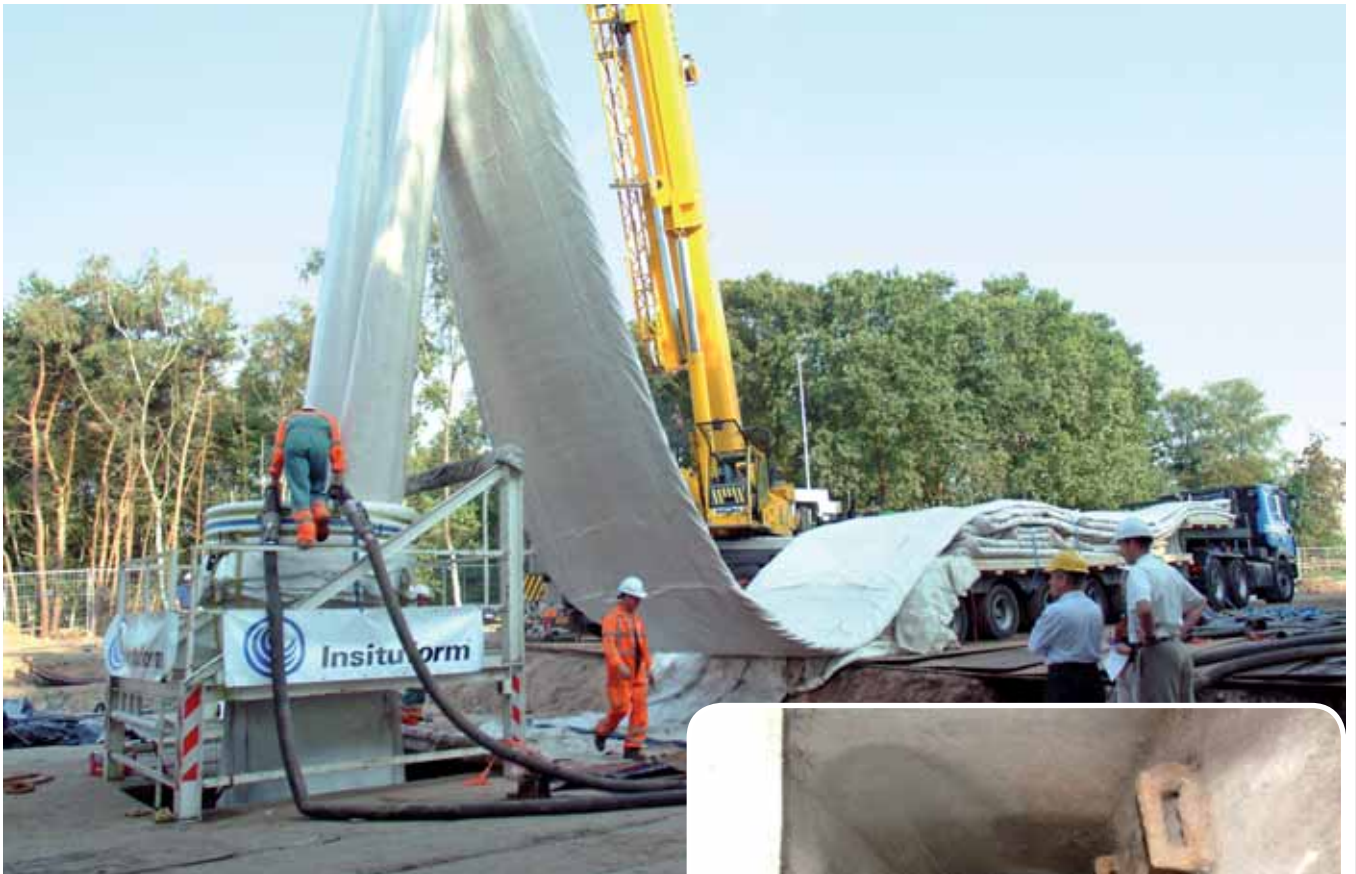
Transportowany rękaw wraz z pojazdem ważył 110 t
