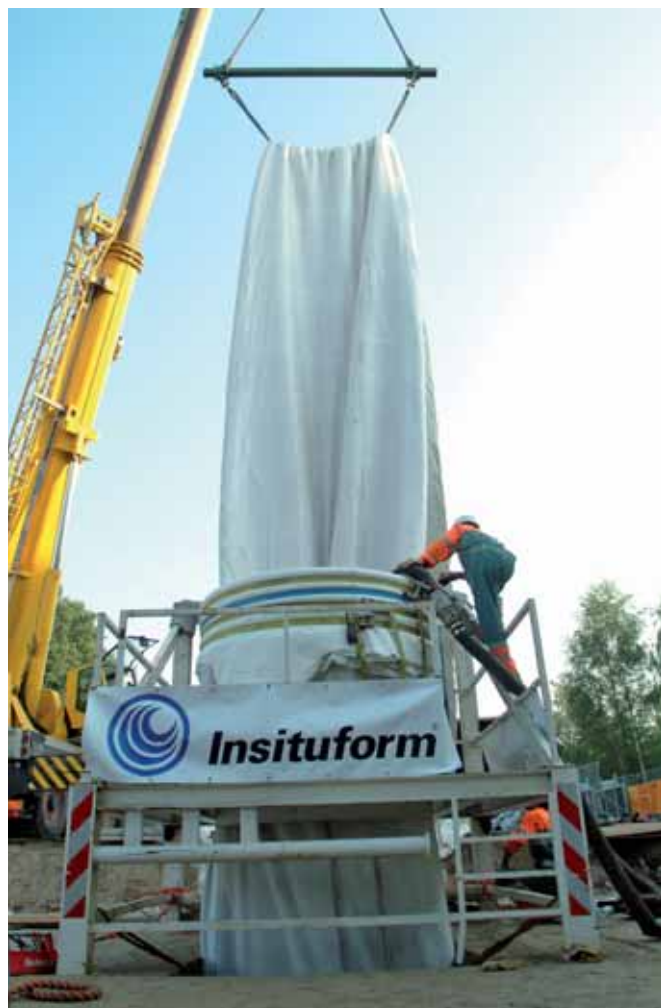
Proces instalacji rękawa DN 2250 i długości 289 m.b.
