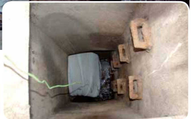
Inwersja, czyli odwracanie rękawa w kanale
