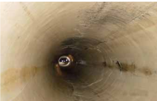
Kanał po renowacji rękawem Insituform®
