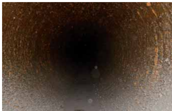
Magistrala po latach użytkowania. Widać osad i korozję, fot. Nurt Sp. z o.o.
