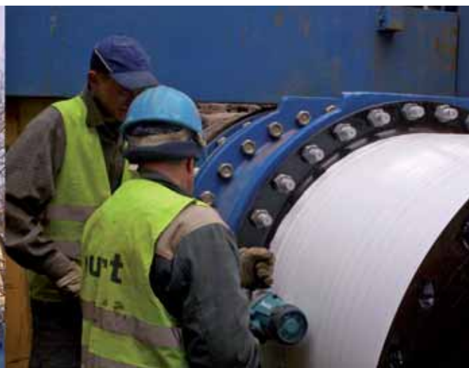
Renowacja magistrali Na Grobli objęła wymianę lub likwidację zasuw i kształtek znajdujących się na rurociągach, fot. Nurt Sp. z o.o.
