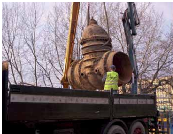
Renowacja magistrali Na Grobli objęła wymianę lub likwidację zasuw i kształtek znajdujących się na rurociągach, fot. Nurt Sp. z o.o.
