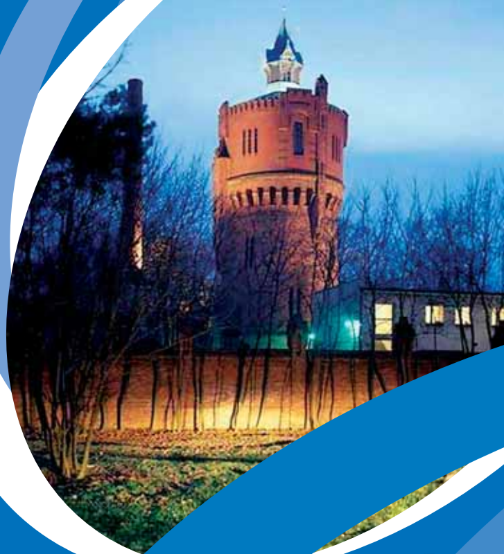
Wieża ciśnieniowa „Stare Bielany” Toruńskie Wodociągi
