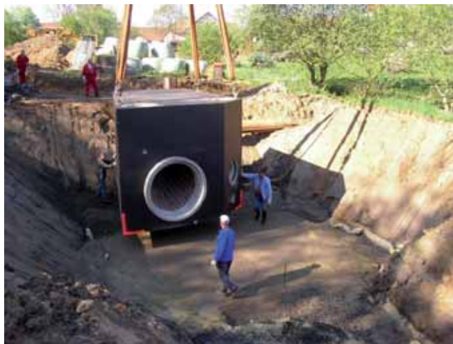
Montaż komory prefabrykowanej
