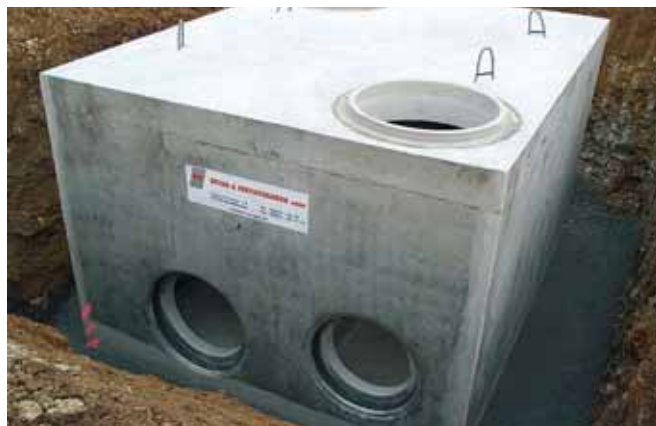
Prefabrykowana komora w wykopie
