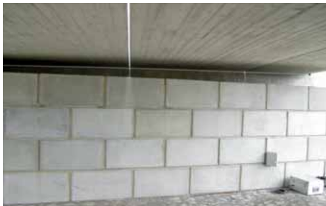
Prefabrykowane elementy składowe obiektu: bloki ściany oporowej i żelbetowe płyty przęsła
