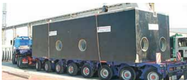
Transport wielkogabarytowego elementu prefabrykowanego
