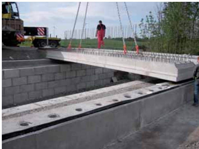
Układanie pierwszego elementu przęsła (P.V. Prefabet Nordhausen)
