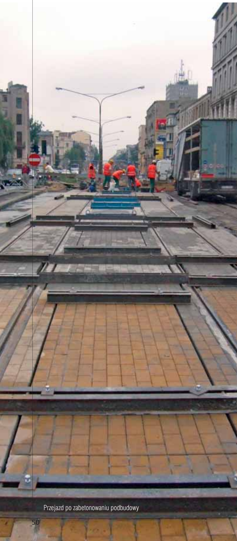
Przygotowanie do spawania termitowego
