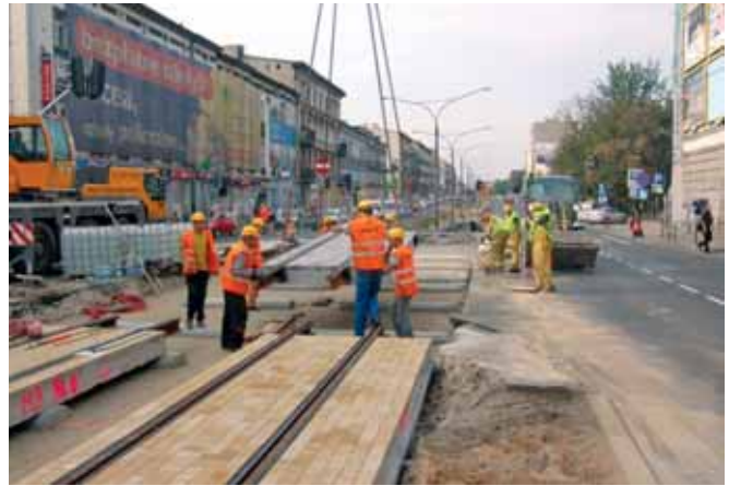
Montaż głównych płyt MODULIX 3
