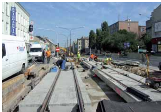
Przygotowanie do spawania termitowego
