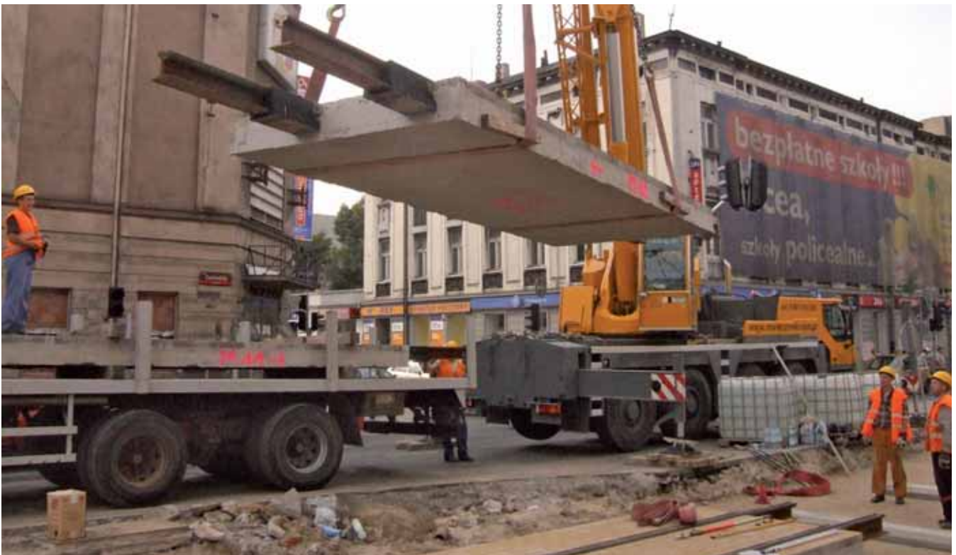
Montaż głównych płyt MODULIX
