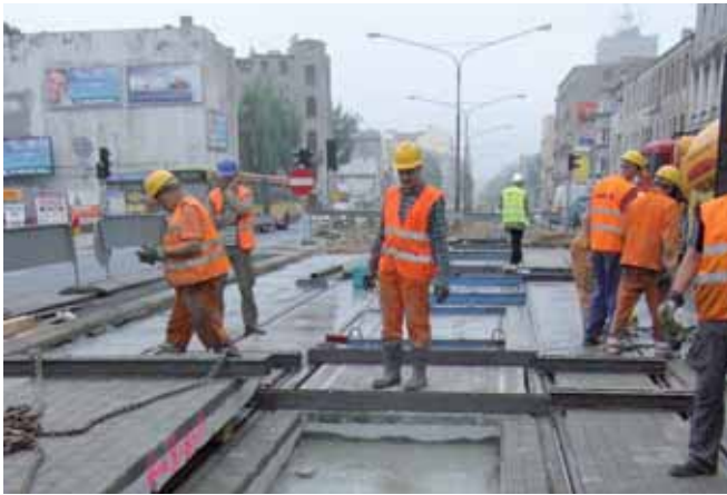
Betonowanie podbudowy
