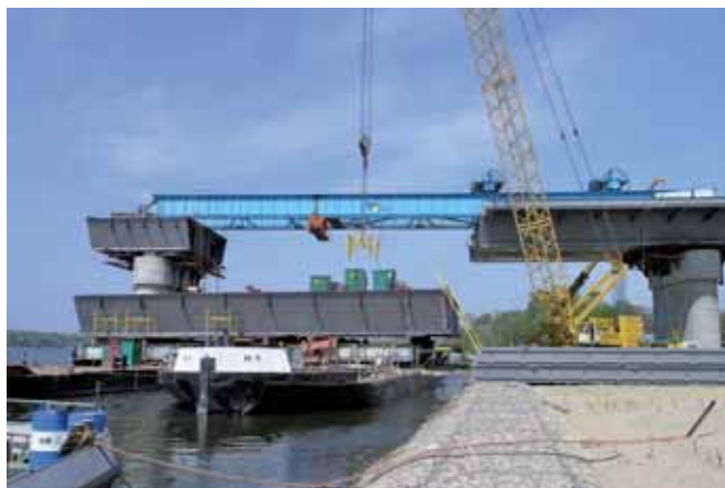
Most w Płocku w trakcie budowy, fot. Hydrobudowa 6 SA
