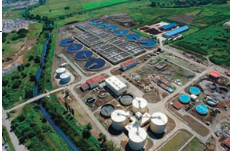
Oczyszczalnia ścieków Płaszów II w Krakowie, obiekty gospodarki osadowej i gazowej – część biologiczna, fot. archiwum MPWiK SA w Krakowie
