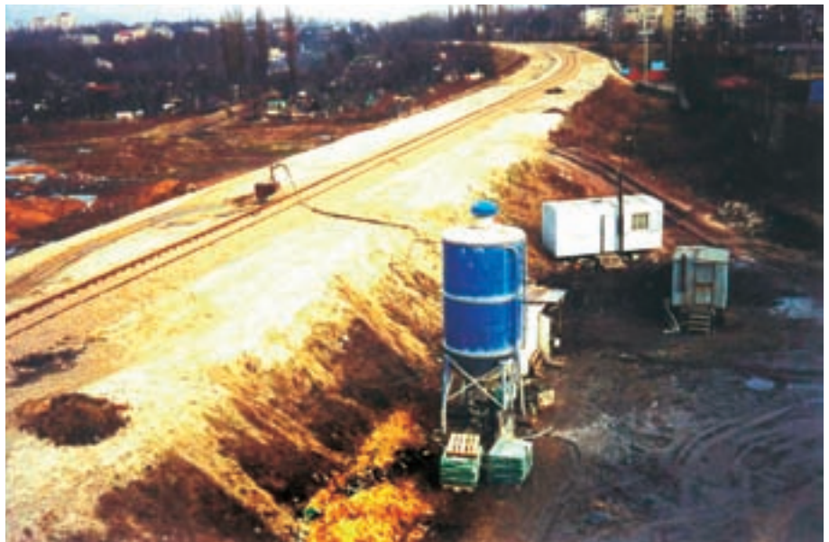
Uzdatnianie pasma podłoża pod nasyp przełożonego szlaku PKP w Chorzowie
