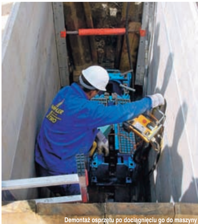
Wciąganie nowej rury HDPE typu SLM 110 x 6,7 mm
