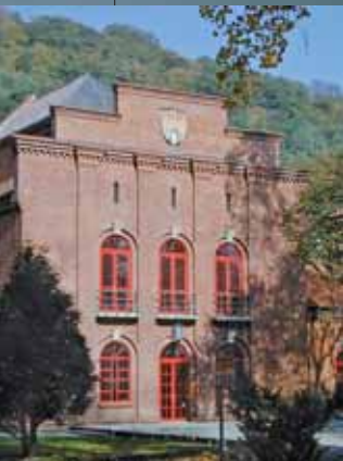
Zakład Uzdatniania Wody Bielany, fot. archiwum MPWiK SA w Krakowie
