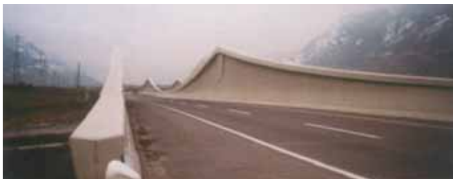
Ryc. 5. Most w ciągu autostrady Martigny – Sion [6]
