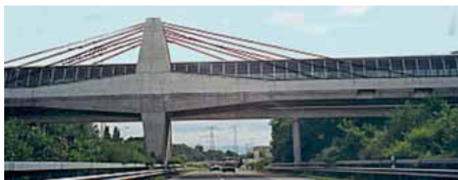
Ryc. 9. Wiadukt nad autostradą Genewa – Lyon, fot. G. Łagoda
