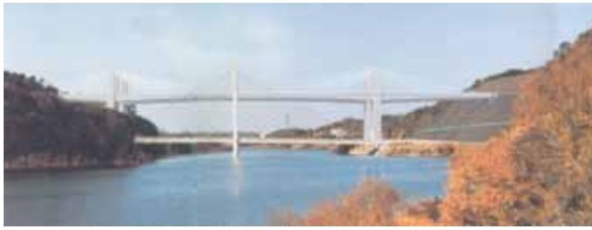
Ryc. 4 a. Most Tsukuhara w Japonii [9] w widoku za mostem podwieszonym
