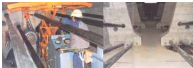
Ryc. 11. Wnętrze przekroju skrzynkowego ze sprężeniem zewnętrznym [9]
