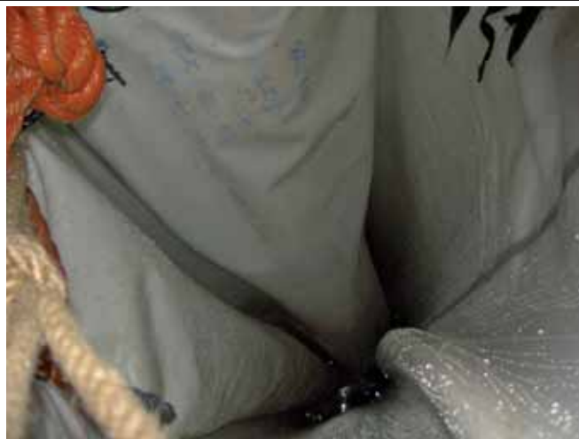
Odcinek pionowy – wprowadzenie rękawa Insituform®
