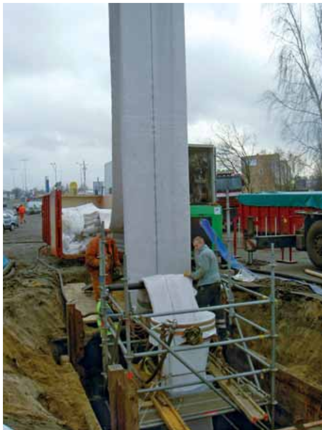
Instalacja rękawa DN 1000 – 162 mb; kanał położony na głębokości ok. 8 m
