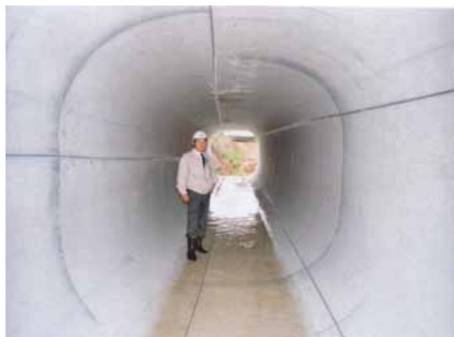
Największy zainstalowany rękaw Insituform® – DN 2750 pod rzeką Onga w Japonii
