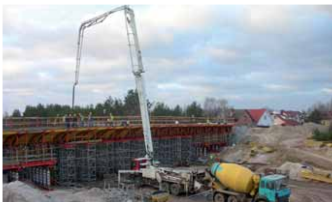
Budowa mostu nad rzeką Wartą
