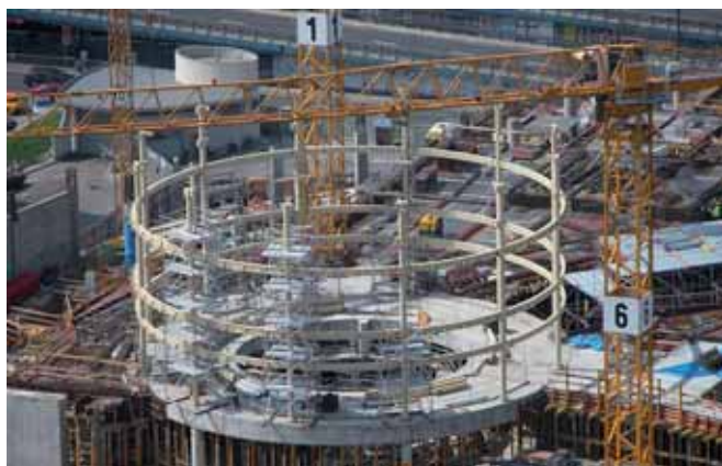
Plac budowy – Złote Tarasy
