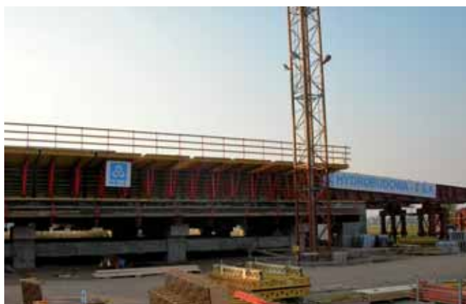
Budowa mostu nad rzeką Wartą
