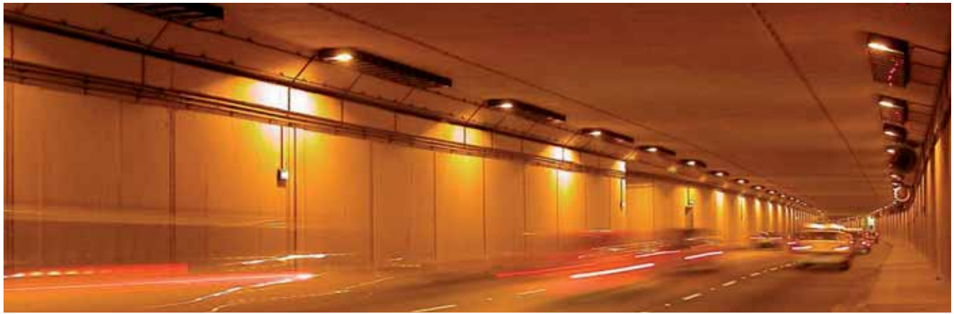
Tunel drogowy na odcinku ul. Karowa – most średnicowy
