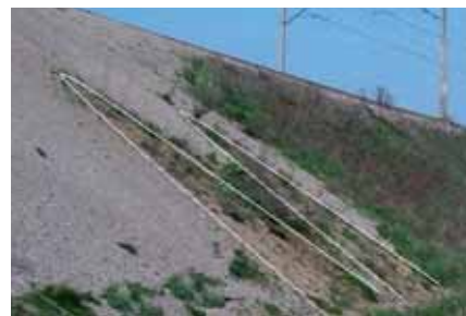
Ryc. 5. Zrekonstruowany nasyp. Białą linią zaznaczono zasięg podciągania wody gruntowej, fot. Geopartner
