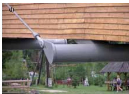
Ryc. 3. Szczegóły konstrukcyjne: a) widok na podparcie pomostu na pylonie, b) łożysko, c) i d) zakotwienia want w przyczółku i poprzecznicach przęsłowych
