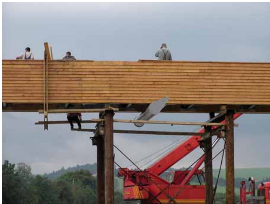
Ryc. 5. Montaż pomostu kładki na podporach tymczasowych, lipiec 2006
