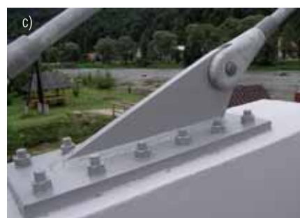
Ryc. 3. Szczegóły konstrukcyjne: a) widok na podparcie pomostu na pylonie, b) łożysko, c) i d) zakotwienia want w przyczółku i poprzecznicach przęsłowych
