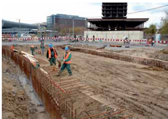
Roboty przygotowawcze pod wykonanie stropu tunelu, KST Kraków, fot. J. Bochajczuk, archiwum PeBeKa SA
