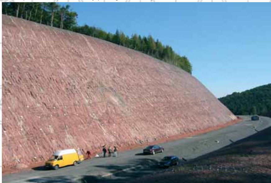
Projekt zabezpieczenia skarpy na autostradzie A-63 w okolicach Kaiserslautern, Niemcy
