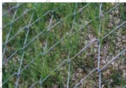
System TECCO® w połączeniu z matą vegetacyjną
