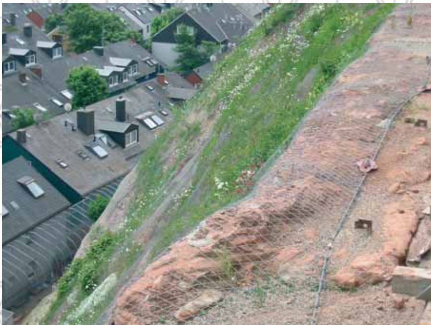
Zabezpieczona skarpa skalna na wyspie Helgoland, Niemcy
