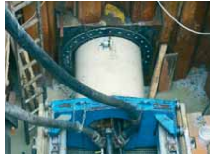
Fot. 6. Rury przeciskowe – DTW w Krakowie
