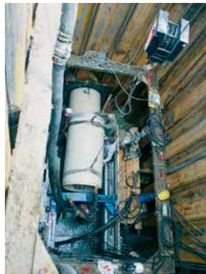
Fot. 5. Rury przeciskowe – DTW w Krakowie
