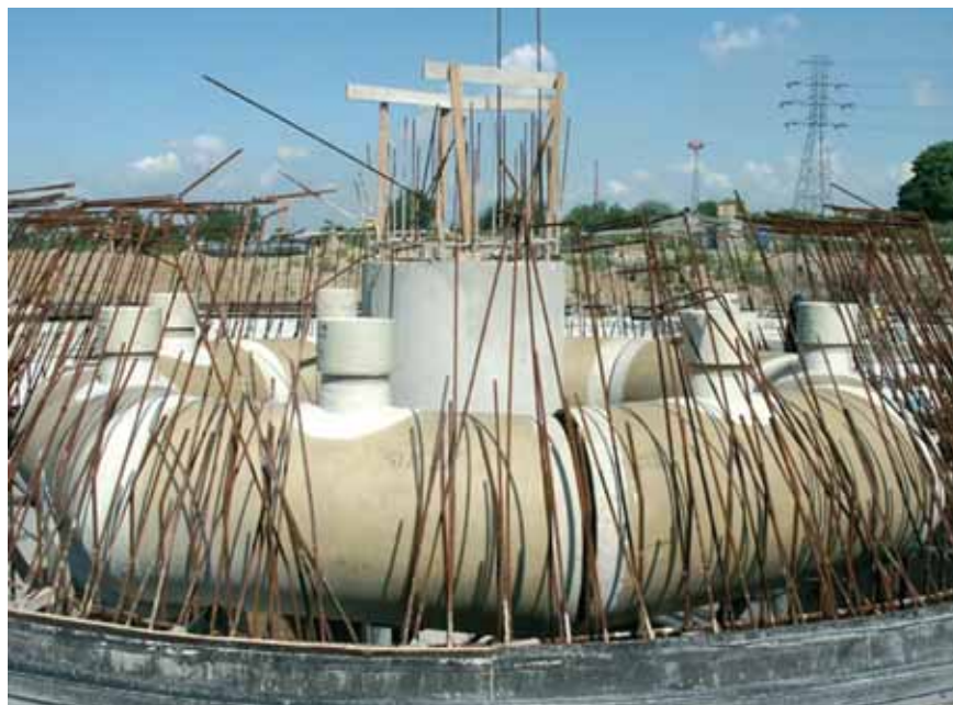
Fot. 1. Oczyszczalnia ścieków w Krakowie Płaszowie
