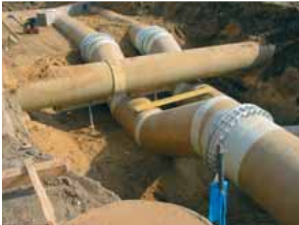
Fot. 4. Sieci technologiczne w ZPW Na Grobli we Wrocławiu
