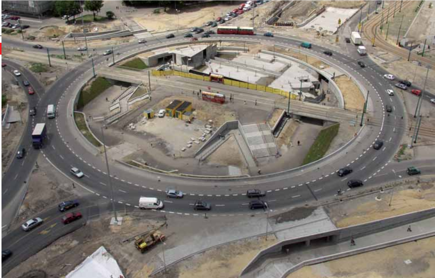
Rondo im. J. Ziętka – w trakcie przebudowy
