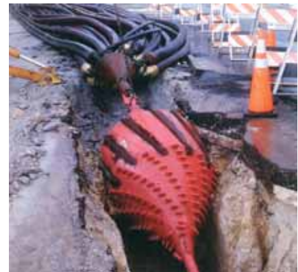
Rys. 9. Wciąganie kilkunastu przewodów kablowych za rozwiertakiem [4]
