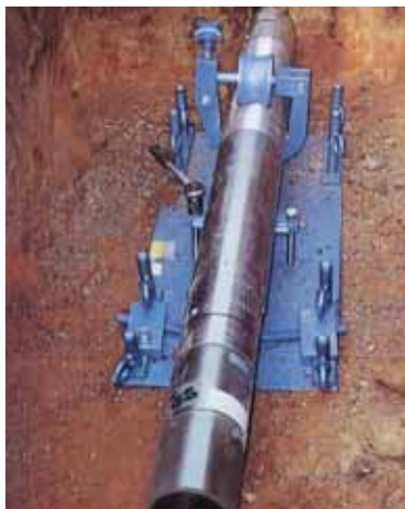
Rys. 13. Przebijak pneumatyczny umieszczony w łożu [9]
