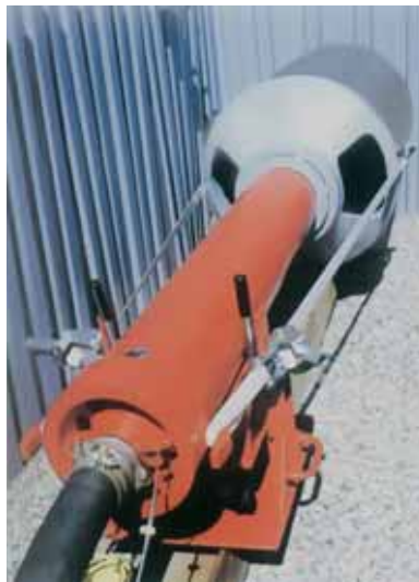
Rys. 18. Wbijanie rur stalowych. Na pierwszym planie przebijaćki pneumatycznej umieszczonej w łożu, na drugim planie pierścienie pośrednie (stożki redukcyjne), adapter, wbijana rura stalowa [9]
