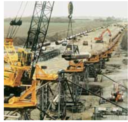
Rys. 8. Rurociąg przygotowany do wciągania ułożony na specjalnej konstrukcji wsporczej [1]
