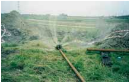
Rys. 10. Płuczka bentonitowa wypływająca pod ciśnieniem z dysz rozwiertaka - rozpoczęcie II etapu robót rozwiercania (zdjęcie własne)
