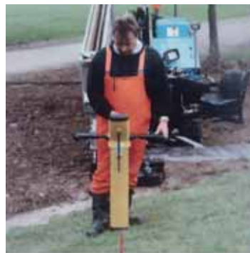
Rys. 12. Namierzanie sondy i odczyt parametrów przewiertu [9].
