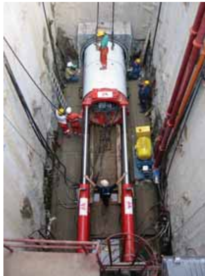
Rys. 6. Główna stacja przeciskowa [7]
