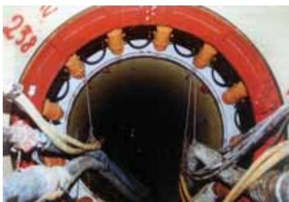
Rys. 8. Widok pośredniej stacji przeciskowej od wewnątrz rurociągu [3]
