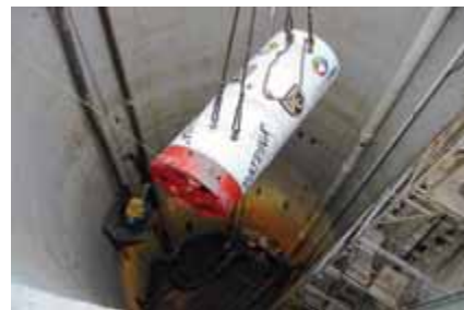
Rys. 1. Głowica do mikrotunelowania opuszczana do komory startowej [7]
