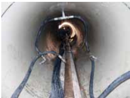
Rys. 7. Wnętrze wbudowywanego rurociągu z dyszami rozmieszczonymi na obwodzie rury [1]
