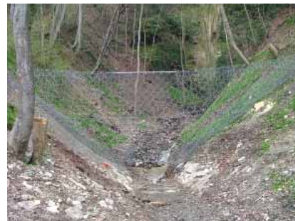
Księstwo Lichtenstein – Bariera gruzowa firmy Geobrugg, chroniąca przed splayami gruzowymi
